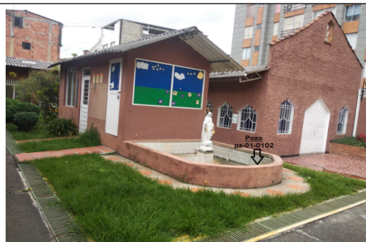
Foto No. 2. Vista general de la ubicación del pozo
