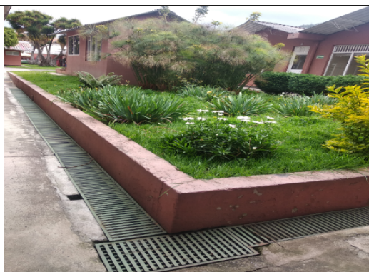
Foto No. 5. Canaletas de conducción agua del pozo
